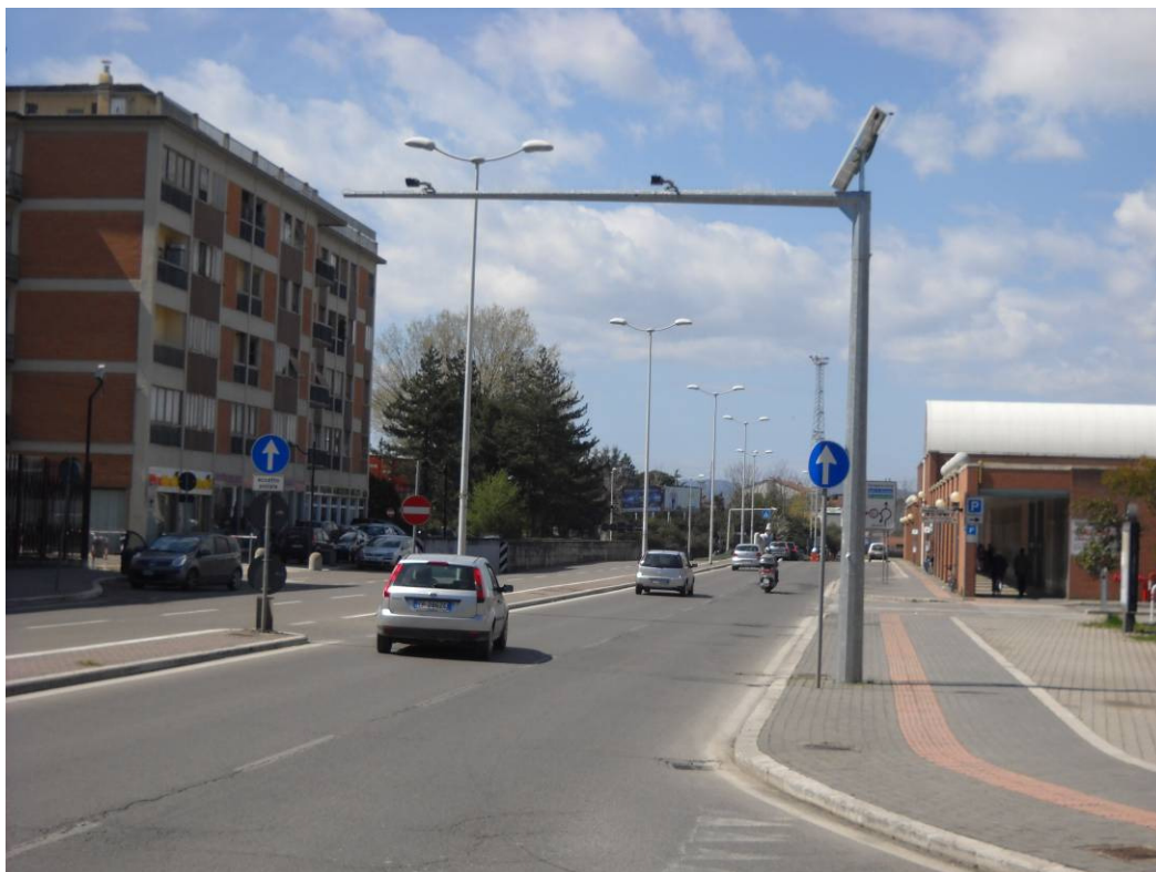
Figura 32. Sezione di monitoraggio e classificazione del traffico n° 3 (via Baldaccio): vista d'insieme
